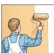
7. Après le séchage, recouvrir le papier avec une peinture émulsion de qualité supérieure en conformité avec DIN EN 13300.
